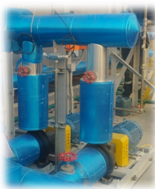
Sistema de bombeo para recirculación de agua helada para Chiller - Nexa Resourse Cajamarquilla
